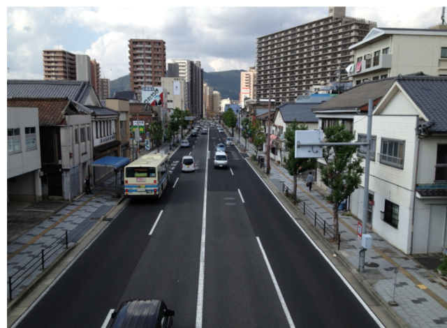
(変電所前陸橋から佐世保駅)
